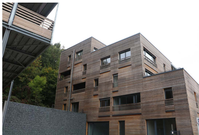
Photo: Differdange; Fonds du Logement
